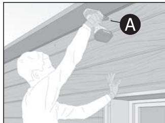
Прикрепите доску наверху с помощью гвоздей или саморезов и подкрасьте их. Также вы можете использовать саморезы с окрашенными шляпками в цвет материала.
